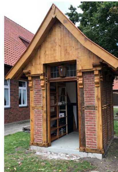
Die Klinker und die Tür sind drin
